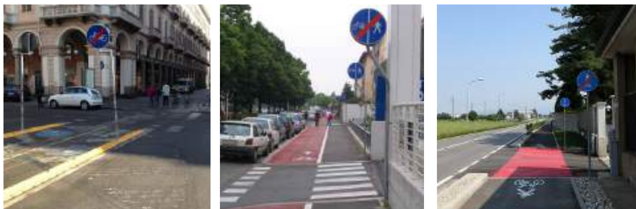
Figura 3.26 - Utilizzo improprio del cartello "Fine pista ciclabile" in corrispondenza di attraversamenti ciclabili o ciclopedonali.
