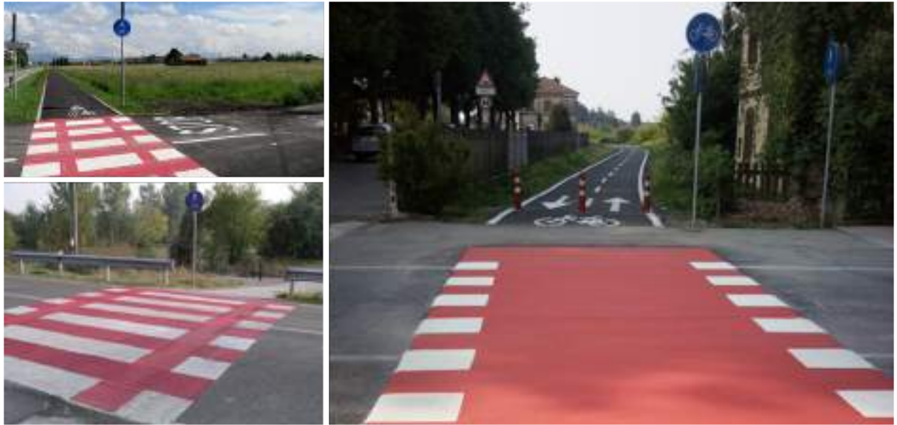
Figura 3.24 - Attraversamento ciclabile semplice (la presenza di archetti e paletti oltre l'attraversamento rappresenta un elemento di pericolosità e difficoltà di passaggio per i mezzi più ingombranti come bici con carrello, tandem etc.)
