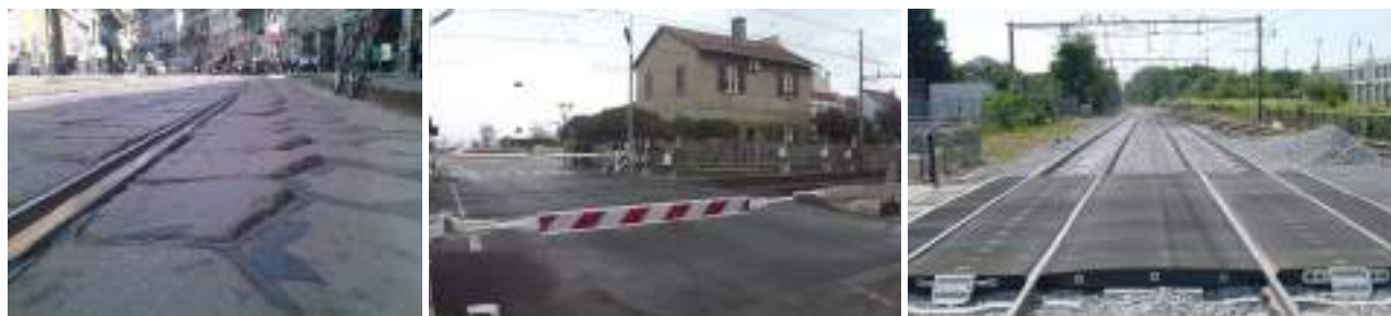
Figura 3.28 - Alcuni esempi di pavimentazioni utilizzate in corrispondenza di attraversamenti su binari ferroviari
