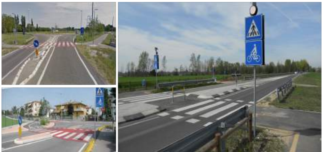
Figura 3.25 - Attraversamento con isola centrale salvagente (la presenza di archetti e paletti in corrispondenza e oltre l'attraversamento rappresenta un elemento di pericolosità e difficoltà di passaggio per i mezzi più ingombranti come bici con carrello, tandem etc.)
