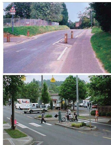
Figura 4.39 - rilievo Strettoie e isole centrali spartitraffico
