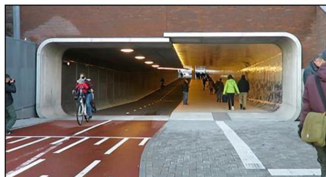
La fluidità e la sicurezza di un percorso ciclabile in sovrappasso o sottopasso sono assicurate da un percorso quanto più possibile rettilineo e lungo il quale sia possibile avere una buona visuale durante l'intero attraversamento.
