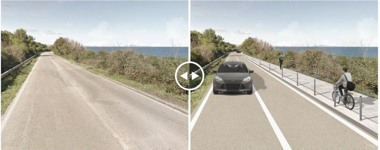
Figura 3.2 - Inserimento pista ciclopedonale affiancata al corpo stradale mediante gli interventi n. 1 e 3
