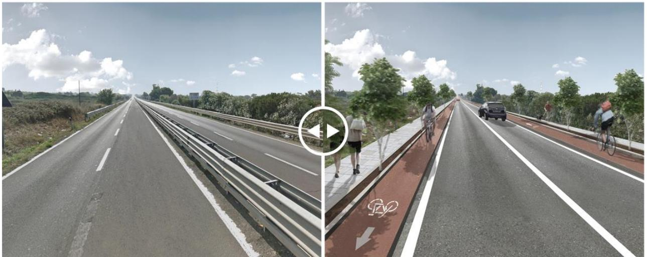
Figura 3.3 - Inserimento pista in sede propria monodirezionale affiancata al marciapiede mediante l'intervento n. 1
